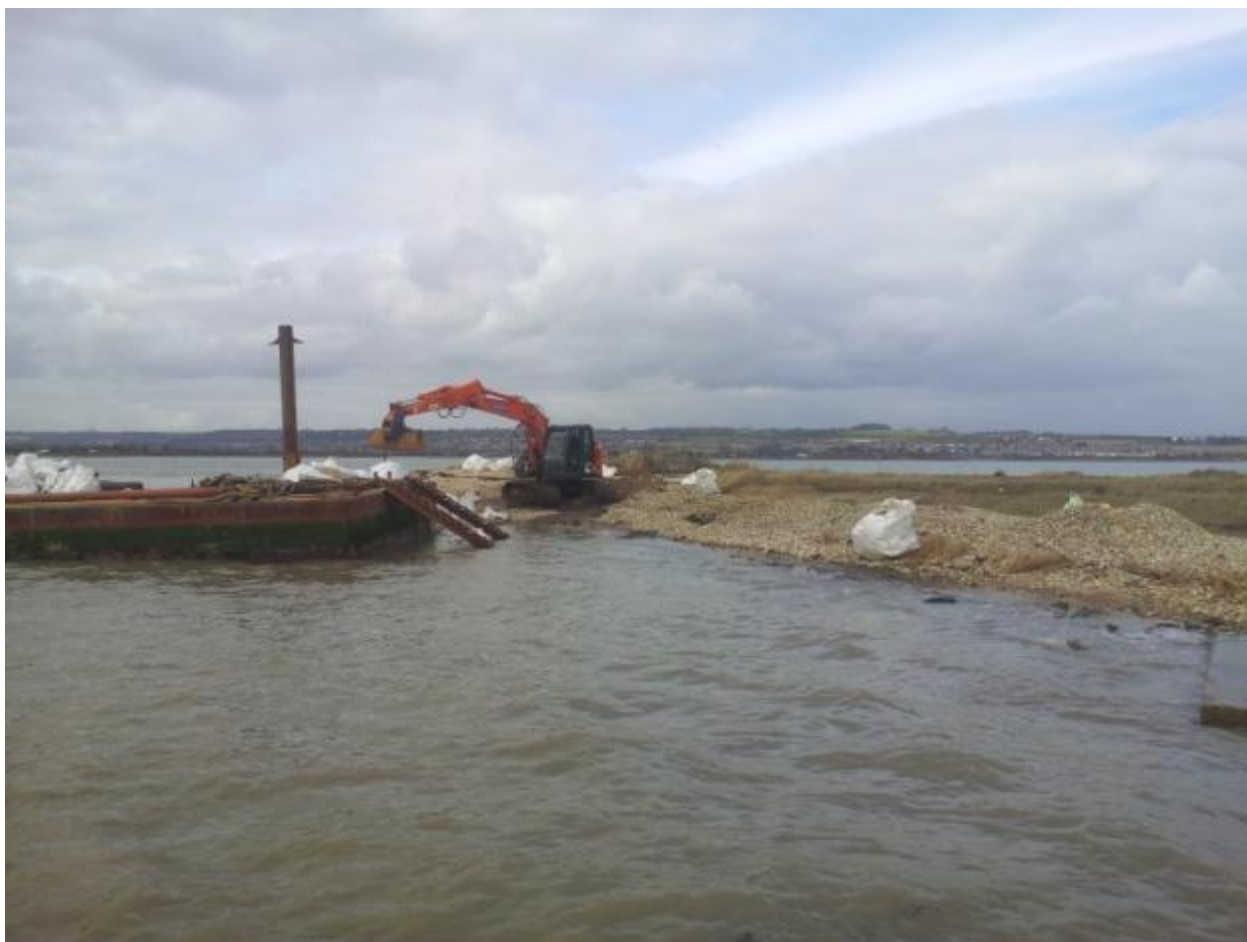
Figure 7. Excavatrice procédant au placement des sacs de gravier dans des paramètres admissibles sur Bakers Island, 2014.
