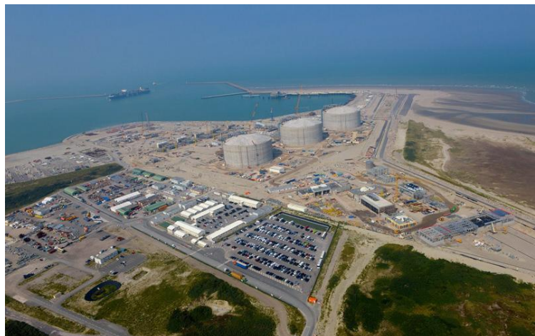
Figure 18 : Chantier du terminal méthanier et plage du Clipon
